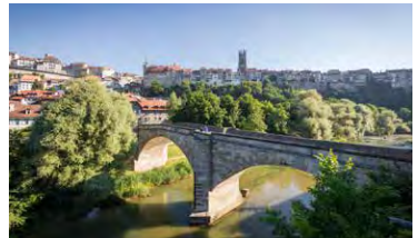
Pont de St-Jean Sankt-Johann-Brücke St. John's Bridge (1746)
