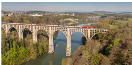
Viaduc de Grandfey Grandfey-Viadukt Grandfey-Viaduc 1862-1927
